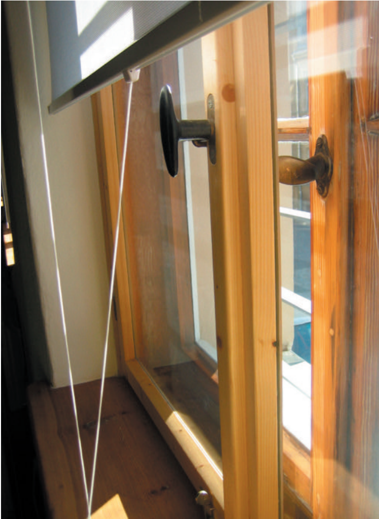
aufgearbeitetes Kastenfenster, Detail, September 2005 | Foto: Nora Kreißl
