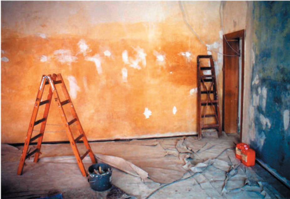
Malerarbeiten Wohn- und Schlafraum, Februar 2005 | Foto: Jörn Michael
