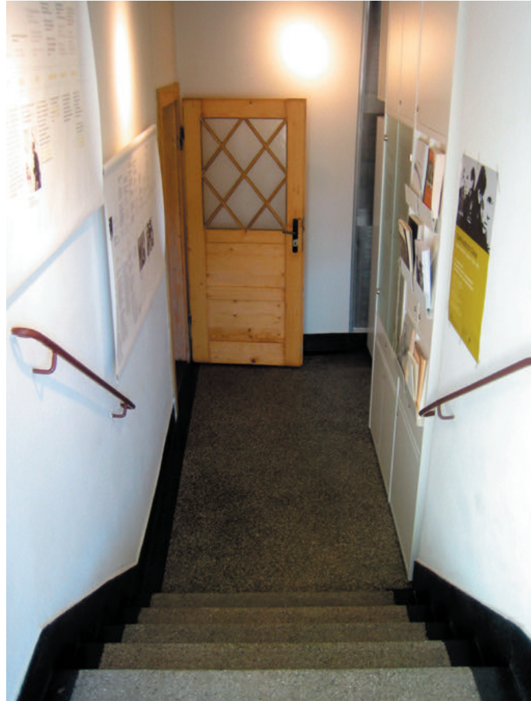
saniertes Foyer mit Terrazzoboden, folgend: aufgearbeiteter Herd, September 2005
