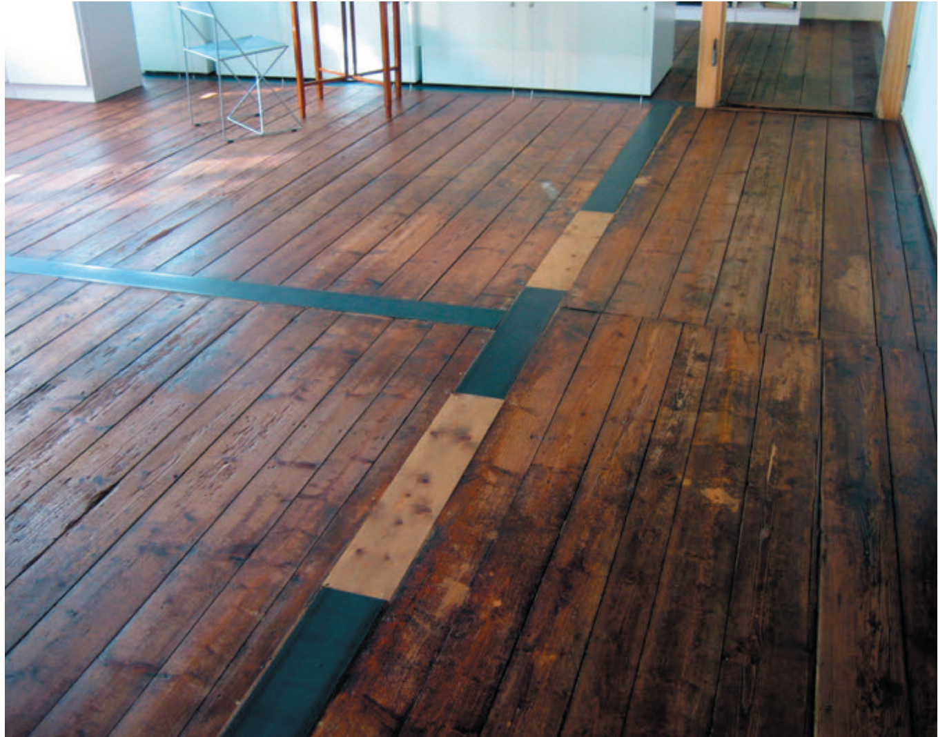
augearbeiteter Dielenboden mit Kennzeichnung der ehemaligen Raumstruktur, September 2005 | Foto: Nora Kreißl
