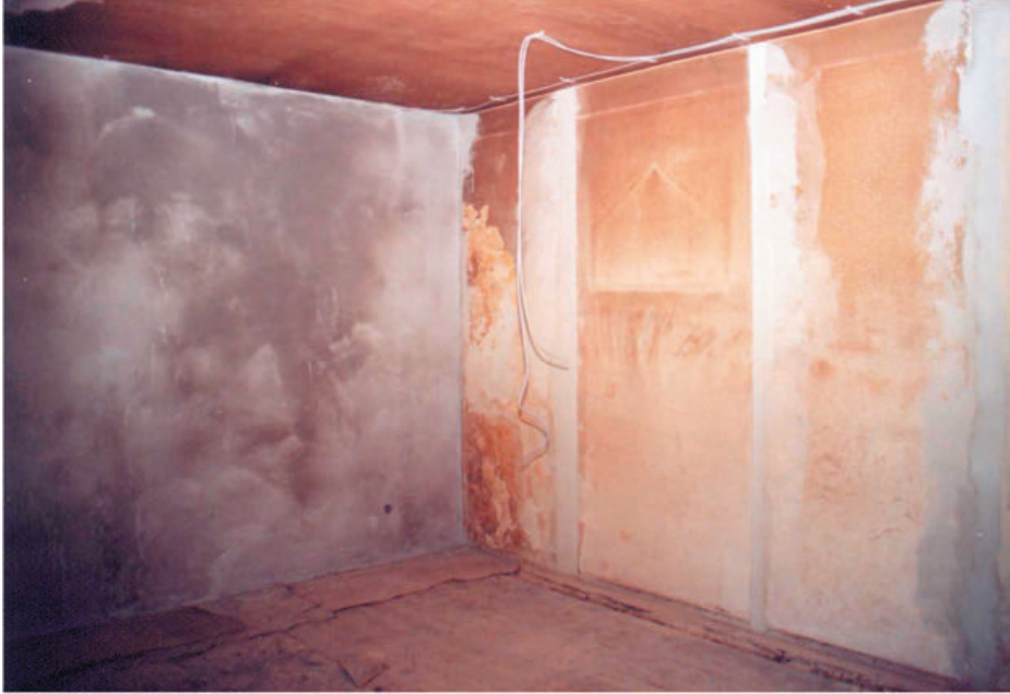
Wohnküche mit trockengelegter und neu verputzter Wand, konserviertes Wandstück mit »belichteten« Stellen, Februar 2005 | Foto: Jörn Michael
